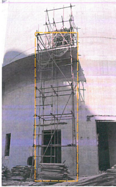
图 1: 脚手架实景图（虚线部分为平台下部脚手架）
