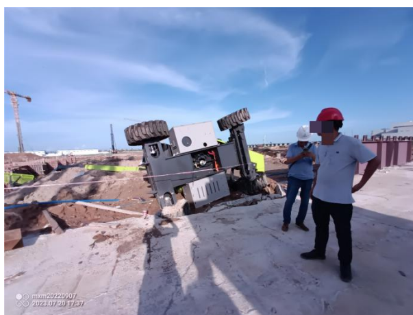
图 7：场地硬化层表面分部状裂纹
