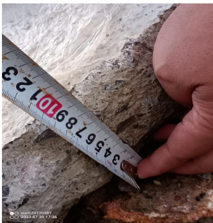
图 5：硬化地面混凝土厚度（90mm） 图 6：硬化地面混凝土厚度(150mm)
