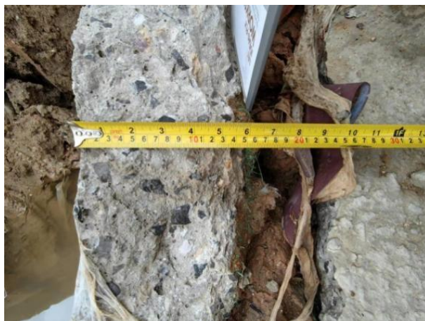
图 5：硬化地面混凝土厚度（90mm） 图 6：硬化地面混凝土厚度(150mm)
