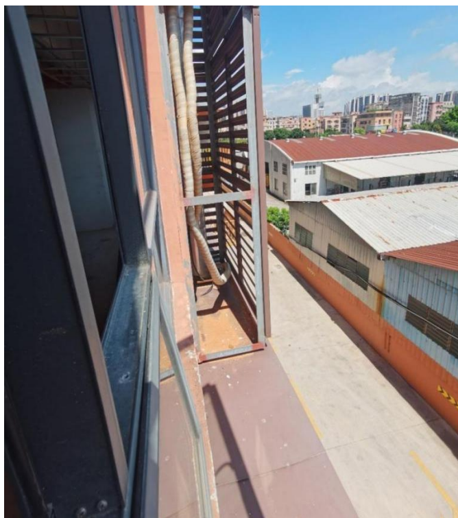
附图 1.20 安装人员在三楼窗外飘台安装了冷媒管
