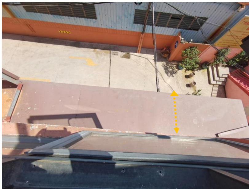
附图 1.17 从三楼窗外观察空调安装作业飘台（宽度 0.561m）
