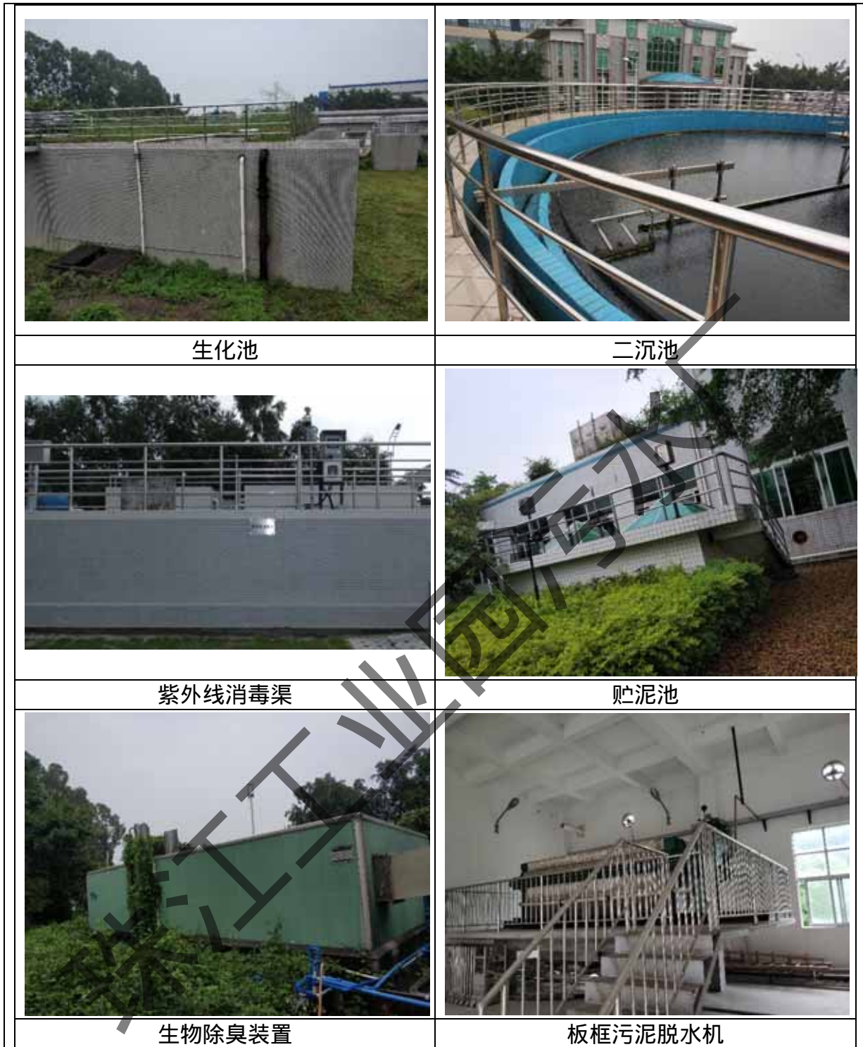
图 1.3 现有工程主要构筑物现状照片
